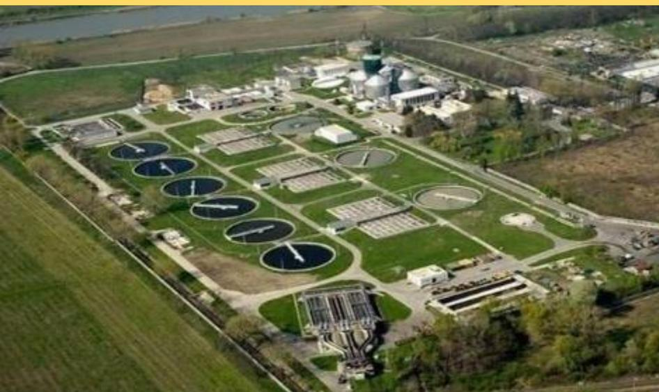
负责布达佩斯市政废水的处理，日处理量高达80000m<sup>3</sup>/d的污水处理厂已经达到其产能的水力上限
