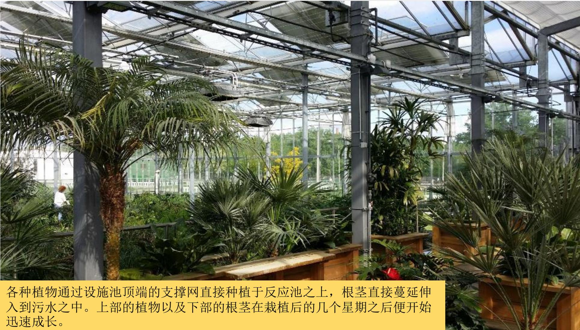
各种植物通过设施池顶端的支撑网直接种植于反应池之上，根茎直接蔓延伸入到污水之中。上部的植物以及下部的根茎在栽植后的几个星期之后便开始迅速成长。
